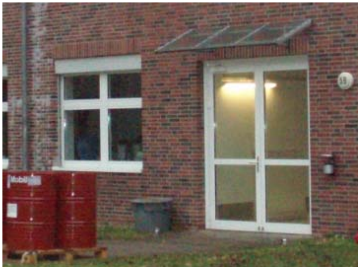
Geb. 59 Rückseite Kellereingang
