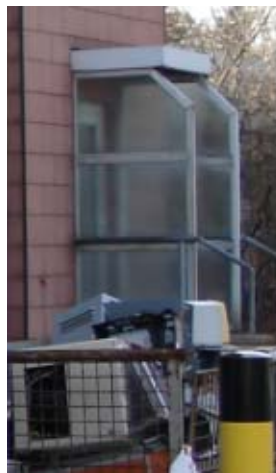
Geb. 47 Eingang Rückseite Parkplatz seitl. Windschutz
